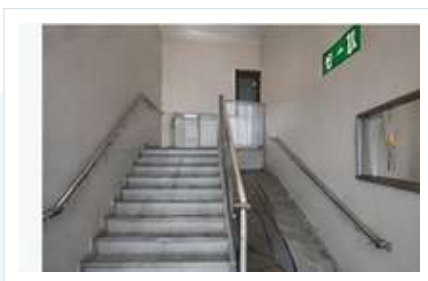
Escalera fija con pasamanos y condiciones de uso seguro.
